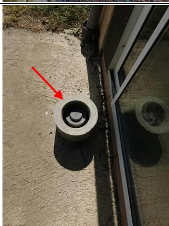
Photo n° PhA005 Localisation : Parties extérieures Ouvrage : Vide-ordures Partie d'ouvrage : Conduits Description : Conduits Localisation sur croquis : 002
