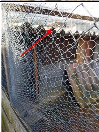
Photo n° PhA004 Localisation : Abris 1 Ouvrage : Bardages et façades légères Partie d'ouvrage : Plaques (fibres-ciment) Description : Plaques (fibres-ciment) Localisation sur croquis : 001
